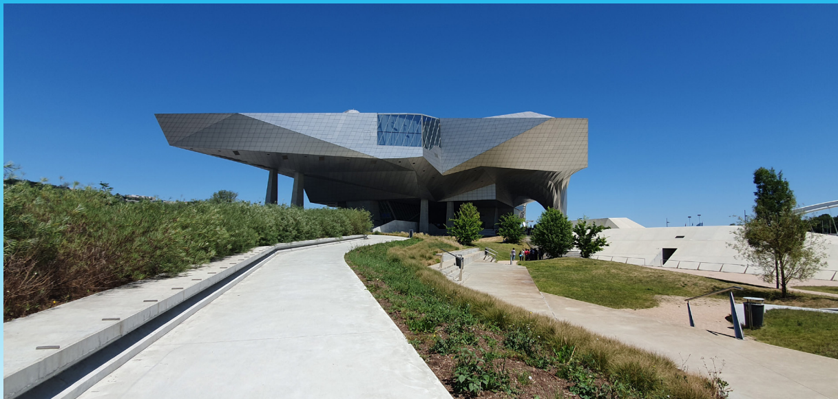
Musée des confluences, Lyon © Syndicat français de la construction métallique
