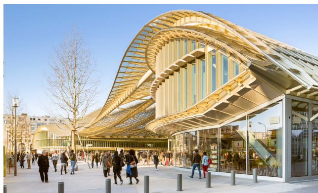
Bâtiment conçu avec l'ingénierie de la sécurité incendie
